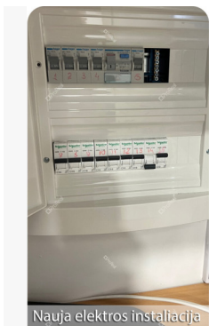
Nauja elektros instaliacija
